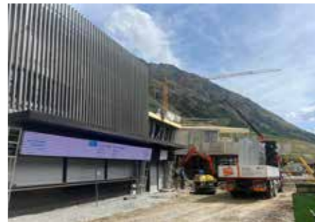
Umbauarbeiten an der Talstation
