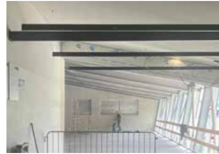
Umbauarbeiten an der Talstation
